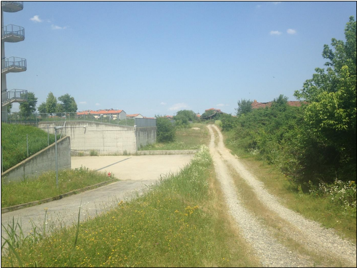
Figura 6 - Vista strada esistente
