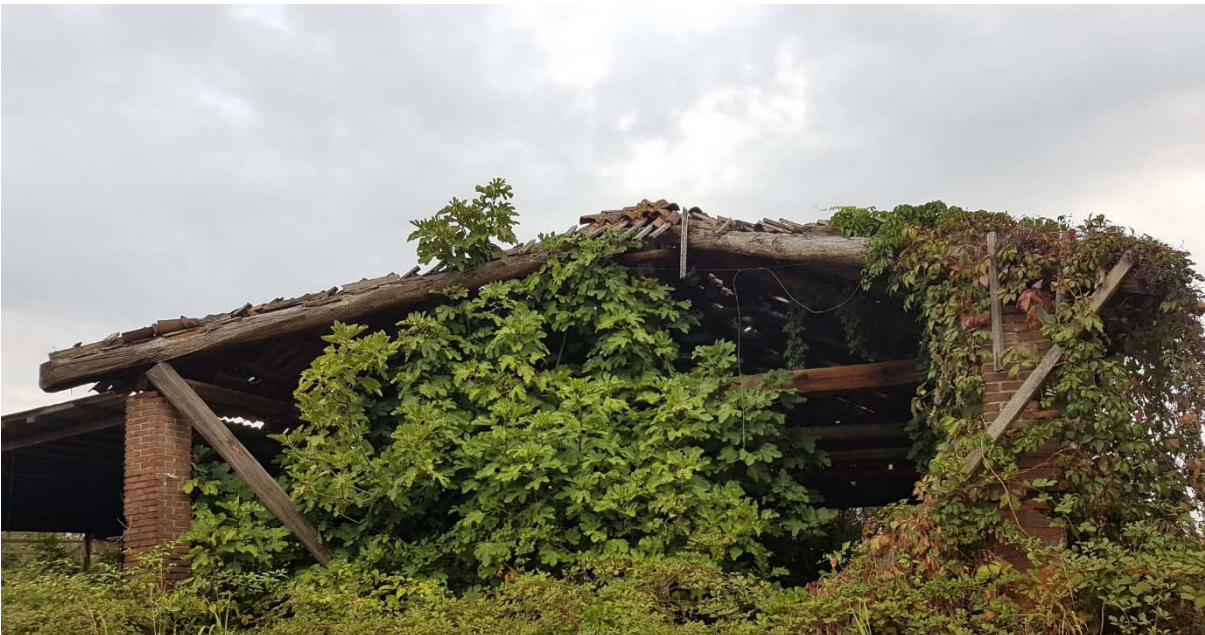
Foto 6 - Fabbricati da demolire
