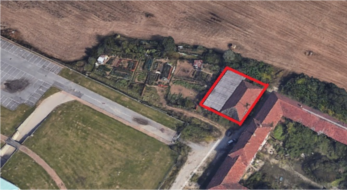
Foto 5 - Area fabbricati da demolire
